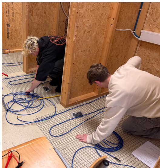
Figur 1: Elever som legger varmekabel i verkstedbås.
